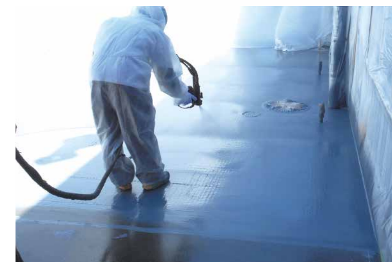
HCスプレー吹付け
