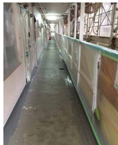
HCスプレー吹付前
