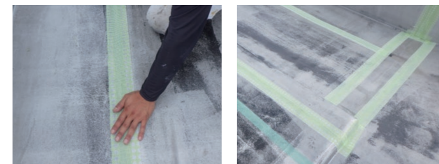
既存シート防水ジョイント部にマルチテープクロス貼付け
