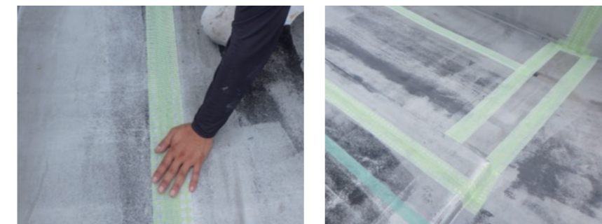
既存シート防水ジョイント部にマルチテープクロス貼付け
