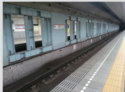
●地下鉄道トンネル
