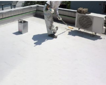
プライマー塗布
