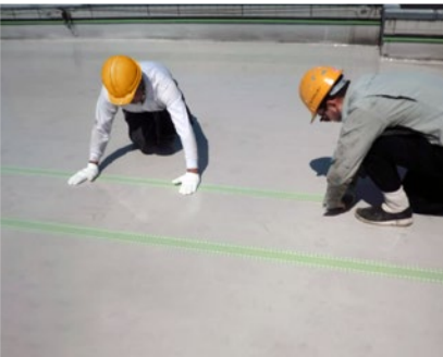
ジョイント部マルチテープクロス貼り
